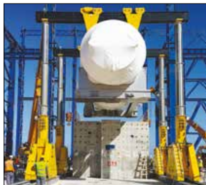
▼ Der Portalkran SBL1100 beim Abladen eines großen Generators, der in einem Kraftwerk installiert werden soll.
