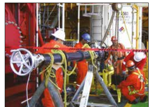
▼ CHT2000 Hot-Tapping-Offshore-Anwendung.
