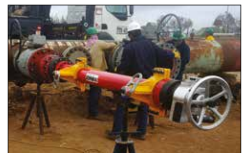
▲ CHT3000 Hot-Tapping-Anwendung für Installation von petrochemischen Rohrleitungen.
