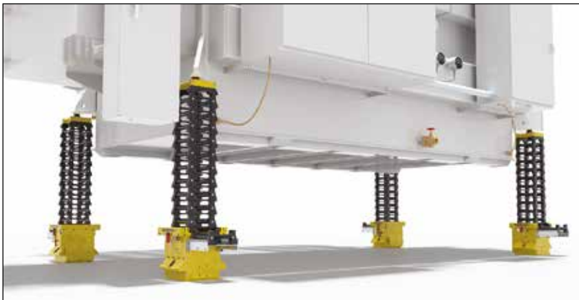
▼ Typischer Aufbau mit 4 selbstsichernden Cube Jacks und Auflageblöcken zum Anheben eines Transformators (Hydraulik-Powerpack und Schläuche nicht abgebildet).
