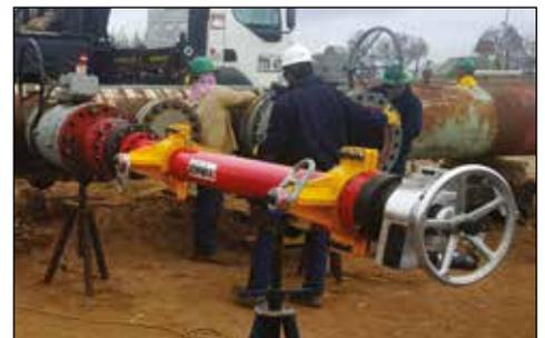
▲ CHT3000 Hot-Tapping-Anwendung für Installation von petrochemischen Rohrleitungen.
